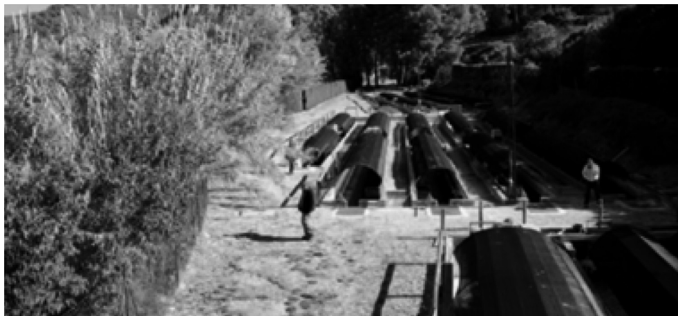
Vista general de tanques preengorde de trucha. Instalaciones GVA en Tuéjar (Valencia)
