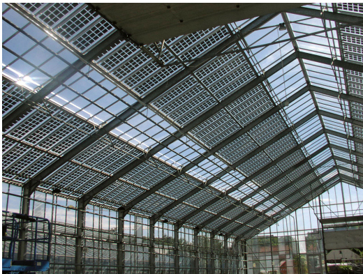
Figura 7. Configuración de módulos semitransparentes a partir de células opacas
