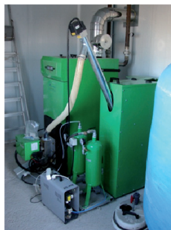
Figura 14a. Quemador de biomasa con todos los elementos, incluso depósito para pellets.
