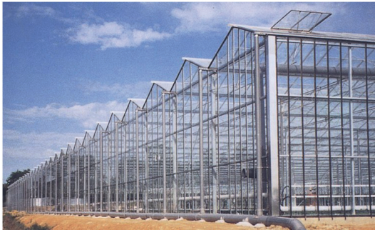
Figura 3. Invernadero de vidrio modelo Venlo holandés. A veces la altura bajo canal llega a los seis metros
