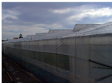
a) Ventanas abatibles en techo y enrollables en laterales
