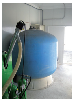
Figura 14b. Sistema de almacenamiento de \text{CO}_2 producido durante la combustión
