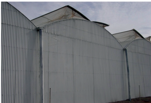
Figura 2. Invernadero multitúnel con ventana cenital doble y paredes frontales de policarbonato
