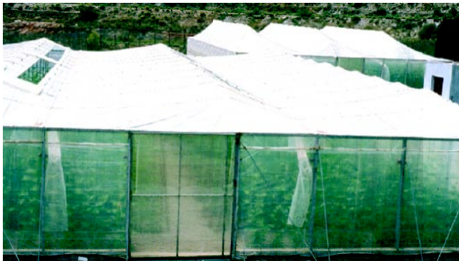
Invernadero de geometría multicapilla “raspa y amagado” asimétrico
