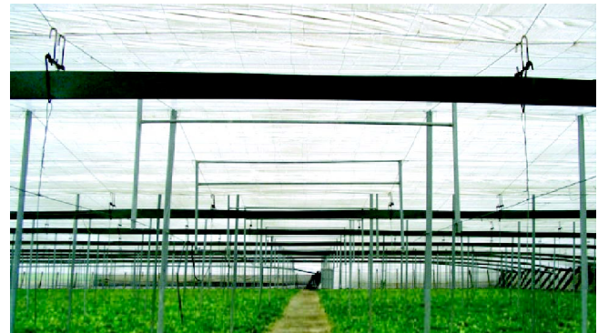
Invernadero de geometría multicapilla “raspa y amagado” simétrico
