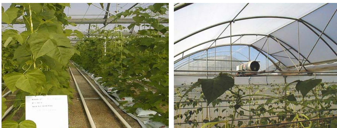
Figura-1. Sistemas de calefacción por tubería aérea con agua caliente (izquierda) y generador de aire con combustión directa (derecha), con cultivo de judía en invernadero Multitúnel .
