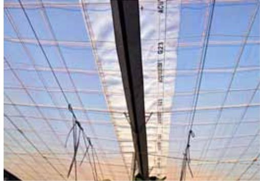
**Figura 4.** Malla anti insectos colocada encima de las canaletas para evitar que las polillas entren por las perforaciones en el plástico.
