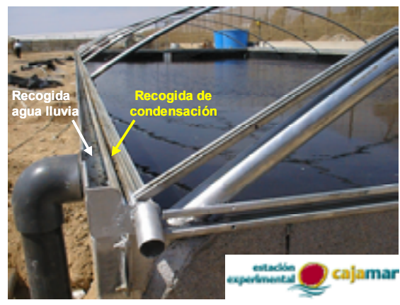
Figura 2. Detalle de las canaletas de recogida de agua dulce.
