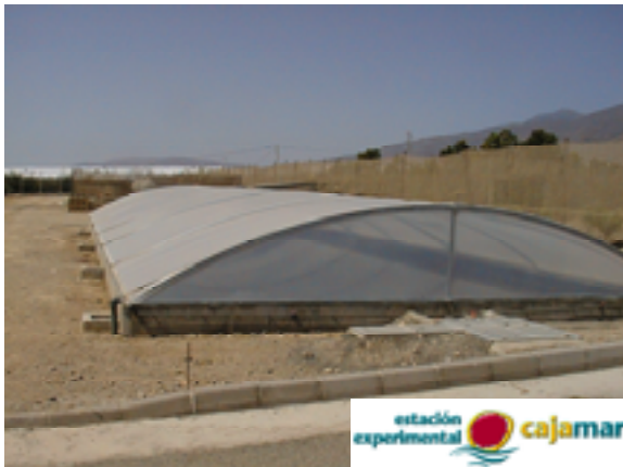
Figura 1. Vista exterior de la desaladora.
