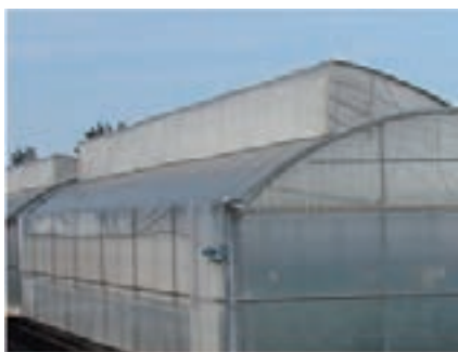
Figura 11. Invernadero con ventilación natural
