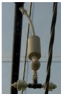
Figura 14. Boquilla de nebulización a baja presión
