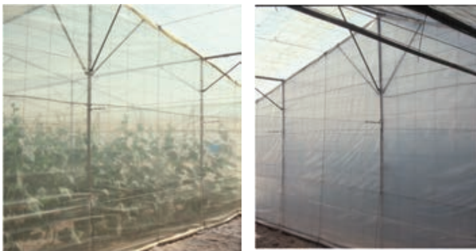
Figura 2. Material plástico para cubierta de invernadero claro (izquierda) & difuso (derecha)
