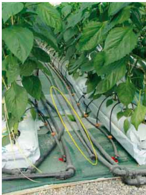
Fotografía 2.16 Detalle de la tubería de suministro de \text{CO}_2 en el interior del invernadero.
