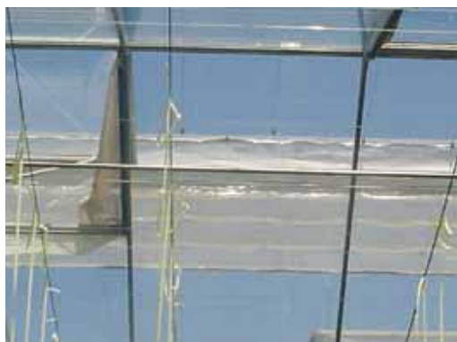
Fotografía 2.12 Vista de la pantalla de sombreo, desde el interior del invernadero, en proceso de extensión.
