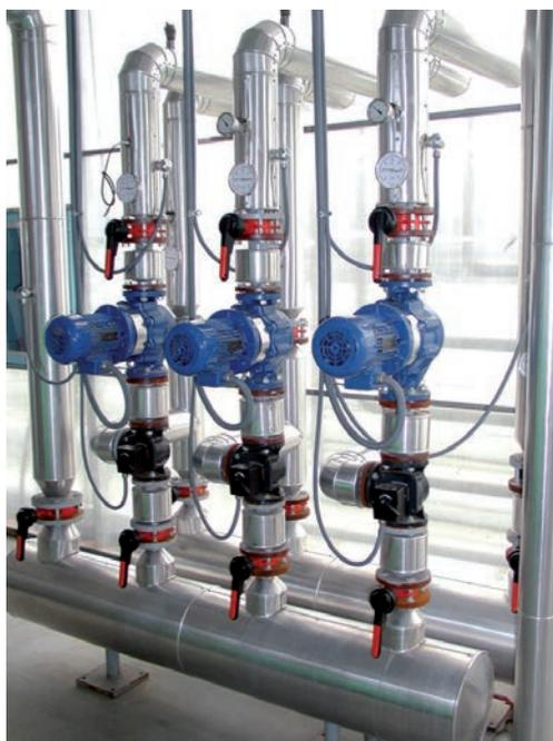
Las pérdidas de calor en la red de distribución de agua caliente suponen un incremento en el consumo del combustible que se precisa para atender una determinada demanda, por lo que el aislamiento térmico se traduce en una economía de combustible. Además la presencia de superficies calientes es una causa potencial de accidentes, por lo que debe controlarse la temperatura superficial de las tuberías de distribución del agua caliente y de la caldera.
