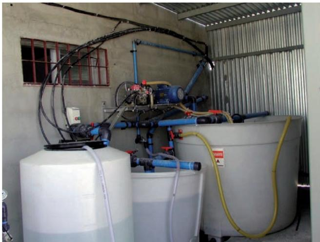
Igualmente es necesaria una válvula de desagüe en el punto más bajo, que permita una total limpieza después de cada tratamiento. Los depósitos más adecuados son los de polipropileno ya que impiden la acumulación de residuos en las paredes, y son resistentes a la corrosión ocasionada por los productos químicos.
