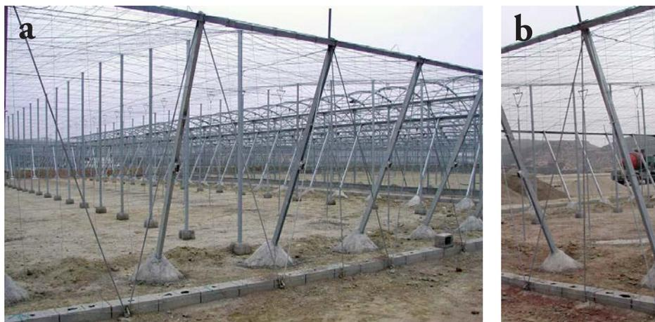
Es mencionable un tipo particular de invernadero plano muy antiguo que está constituido por una estructura de tuberías de hierro galvanizado con una separación de 3 x 3 m (Figura 20). Los apoyos perimetrales se sitúan verticalmente, siendo la altura del invernadero de unos 2,5 m. Actualmente, no se suelen construir pero todavía se puede ver este tipo de estructura en el campo almeriense.
