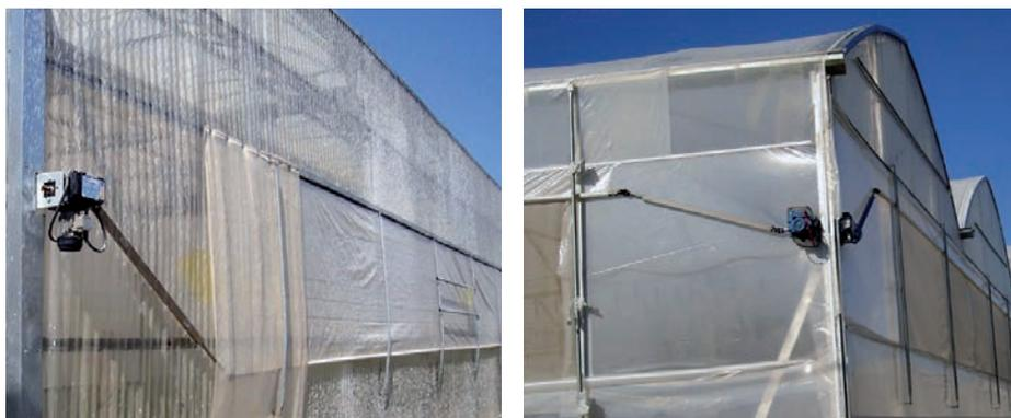
En estas ventanas se fija una franja de plástico de 1-1,5 m de anchura por su parte superior a la estructura y por la parte inferior a un tubo circular que en su extremo está accionado por un motor tubular. Mediante el giro del tubo se consigue enrollar el plástico, abriendo la ventana, o desenrollarlo para cerrar la ventana.
