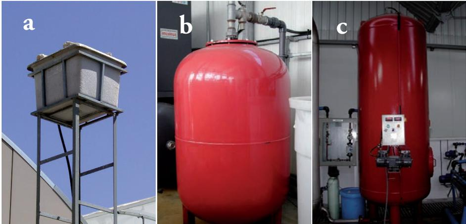
Los vasos de expansión abiertos basan su funcionamiento en la altura manométrica que alcanza el agua al situar un depósito de reserva situado a
