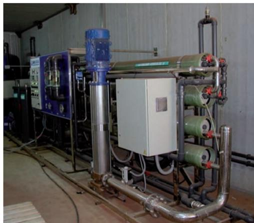
El agua de riego utilizada por el sistema de fertirrigación es una mezcla del agua desalinizada con la bombeada directamente del pozo, variando la mezcla en función de las necesidades de CE de cada cultivo. Así, por ejemplo hay variedades de tomate para las que un mayor contenido en sales en el agua de riego proporciona unas mejores cualidades organolépticas de los frutos.
