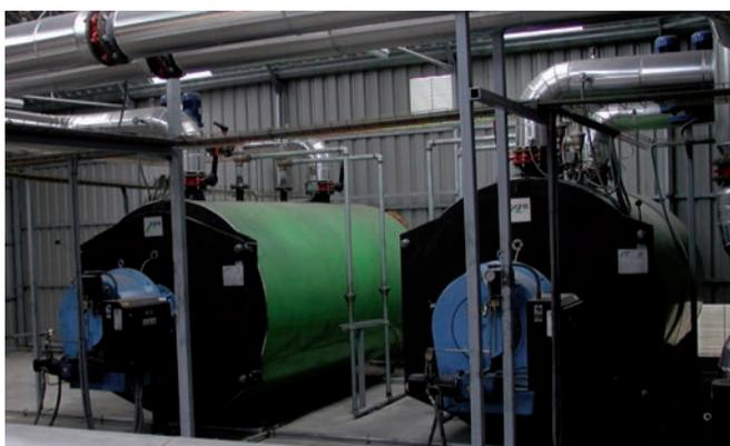
En el caso de los invernaderos, las instalaciones de calefacción deben funcionar bajo condiciones climáticas muy variables. A finales del otoño, cuando empiezan a utilizarse, y al principio de la primavera cuando suele terminar el periodo de calefacción, las necesidades térmicas están muy por debajo de la potencia máxima de calefacción. Esto hace que las calderas tengan que funcionar muy por debajo de su capacidad máxima, lo que conlleva un descenso importante de su rendimiento.
