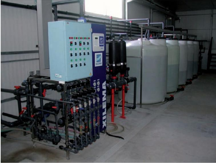
En algunos casos se utilizan bombas de membrana que inyectan la solución fertilizante a un circuito cerrado en el que se colocan las electroválvulas en derivación en «T» que envían el agua a un depósito auxiliar de mezclas y una segunda electrobomba inyecta a mayor presión la mezcla en la red principal.
