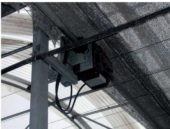
En otros casos la cremallera se puede enlazar directamente a un cable que accionará el mecanismo de apertura y cierre de la malla, al mover los tubos de arrastre a los que va unido. Sin embargo, este sistema presenta el inconveniente de posibles desajustes entre los diferentes paños de malla al producirse diferentes elongaciones a lo largo del cable, lo que se ha de corregir disponiendo una serie de tensores que permitan corregir estos desajustes.
