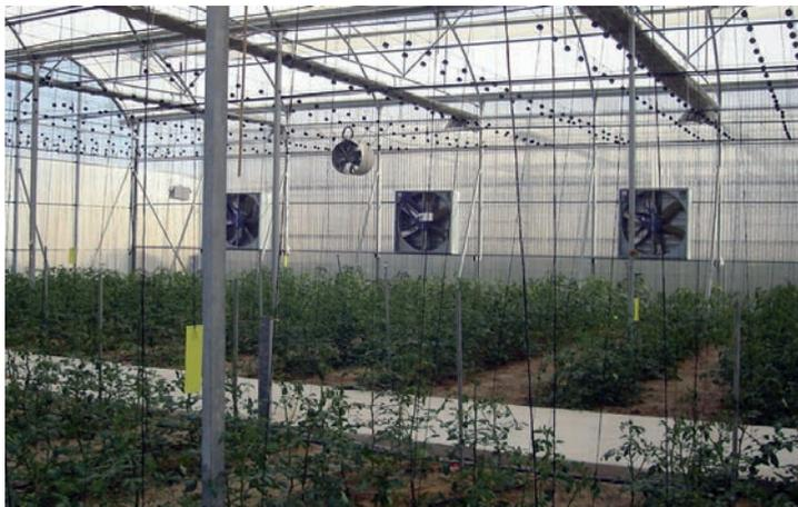
**Figura 60. Vista de un panel evaporador de celulosa desde el interior del invernadero**
