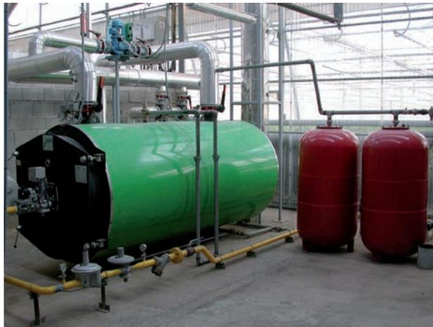
Las calderas utilizadas para calefacción por agua en invernaderos trabajan con presiones de 10-20 bares, y temperaturas de salida del agua entre 60 y 80°C, siendo la temperatura máxima de seguridad de 110 °C. Mediante válvulas de tres vías (Figura 75) se puede hacer recircular parte del agua de retorno, cuando no se trabaja a la potencia máxima, lo que permite regular la temperatura de emisión de las tuberías en función de las necesidades del invernadero.
