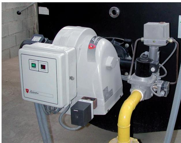
La modulación se realiza por medio de una válvula reguladora de presión colocada en la tubería de retorno, que permite un encendido silencioso, sin explosiones, con una potencia en el arranque de hasta el 35 % de la nominal. El rodete del ventilador, con una presión estática elevada, hace que el funcionamiento del quemador sea insensible a oscilaciones en la sobrepresión de gases de la caldera.
