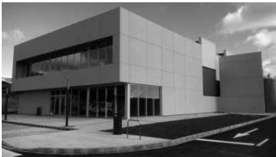
Figura 1. Edificio principal de la biorrefinería de I+D+i CLAMBER
