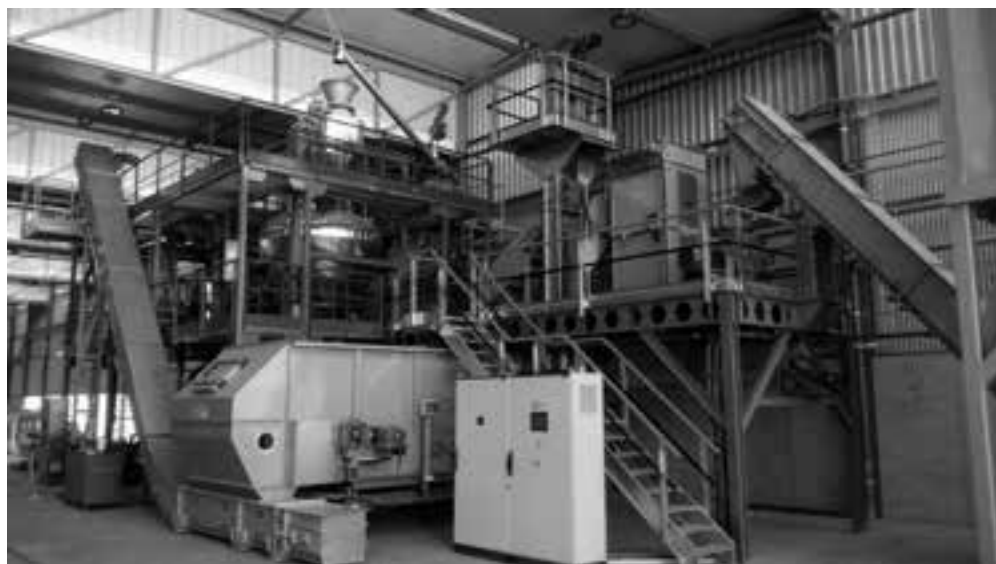
Figura 2. Unidad de acondicionamiento de biomasa lignocelulósica
