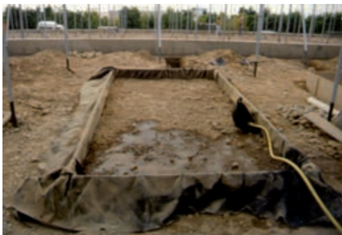
Figura 5. Lisímetro en construcción
