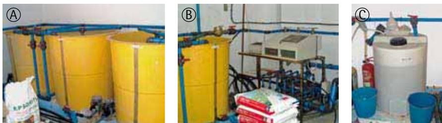
Fotografía 1. Tanques para solución nutritiva concentrada (a), programador de riego (b) y tanque de  $\text{HNO}_3$  para regulación de pH (c).
