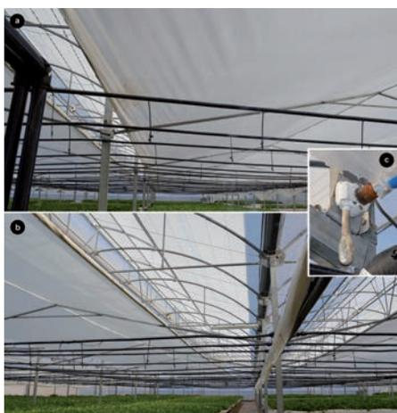
a) Calle desplegada, b) calle plegada –tanto en una como en otra pueden verse las barras metálicas que sirven de guía y sostén al sistema de enrollado y d) detalle del sistema de enrollado.
