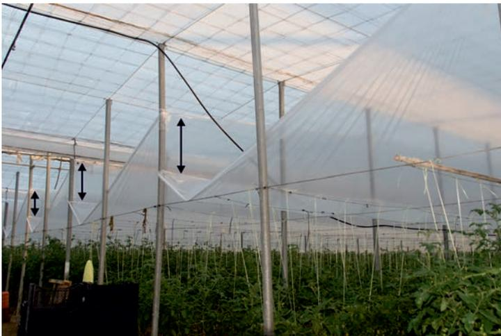
*Nótese la elevada separación de las láminas plásticas en este tipo de doble techo, lo que permite una excelente ventilación, evitando el goteo de la cubierta sobre el cultivo y eliminando totalmente el riesgo de condensación en la cámara inferior.*
