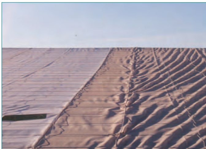
ACUMULACIÓN DE POLVO EN DOS MATERIALES EVA (DERECHA) Y PE (IZQUIERDA), PARA UNA MISMA FECHA DE COLOCACIÓN.
