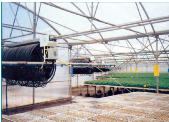
FOTO 3. DETALLE BANQUETAS DE HORMIGÓN Y TREN DE RIEGO.
