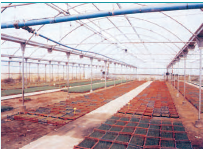
■ FOTO 1. DETALLE COLOCACIÓN BANDEJAS DE PLÁSTICO Y ESTRUCTURA TIPO MULTITÚNEL.
